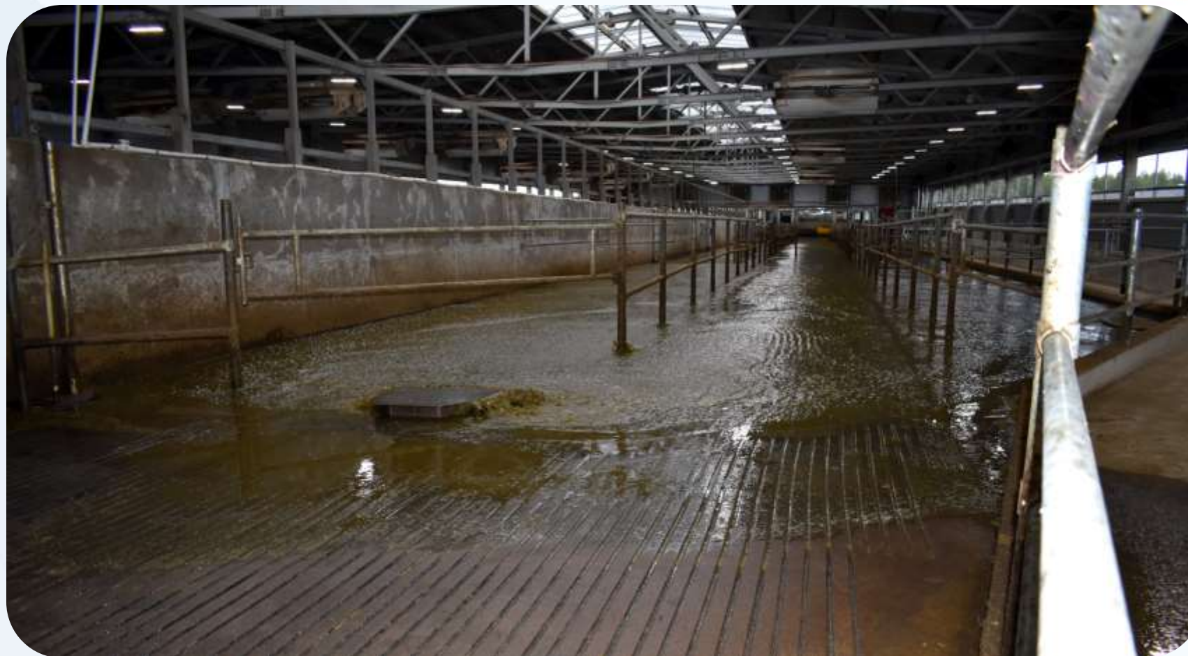
Гидросмыв в накопителе и селекционной зоне
